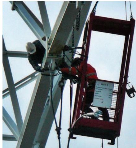
3 Teamarbeit bei komplexer Stahlbaumontage
