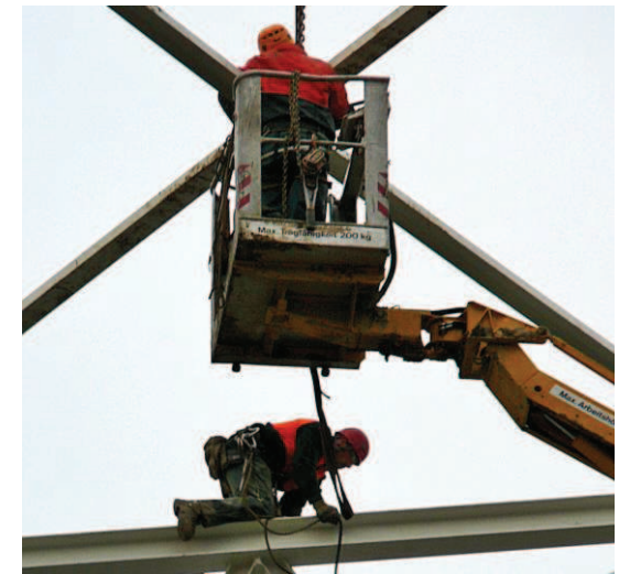
2: Alternative zu Bild 1: Zugang mittels Hubarbeitsbühne
