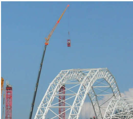
1: Eine sichere Alternative zu einer 85m Kletterpartie zum Fachwerkknotenpunkt des Bogentragwerks ist der Ein- und Ausstieg aus einem Kran-Arbeitskorb oder einer Hubarbeitsbühne (→ länderspezifische Regelungen beachten!)
