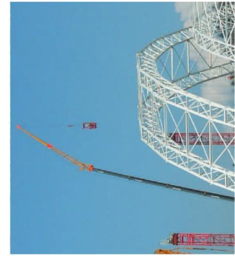
1: Eine sichere Alternative zu einer 85m Kletterpartie zum Fachwerkknorpunkt des Bogentragwerks ist der Ein- und Ausstieg aus einem Kran-Arbeitskorb oder einer Hubarbeitsbühne (→ länderspezifische Regelungen beachten!) Hinweis: Bestehende nationale Bestimmungen bleiben vom Inhalt dieses Dokuments unberührt - Der deutschsprachige Originaltext dieses Dokumentes ist nur auf [www.bauforumplus.eu/absturz](http://www.bauforumplus.eu/absturz) hinterlegt
