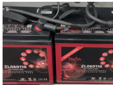
AGM-Batteriekasten.
